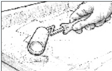
Abbildung 28 Beschichten Sie die Oberfläche, um die Gewebestruktur vollständig auszufüllen, solange das getränkte Glasgewebe noch klebrig ist.
